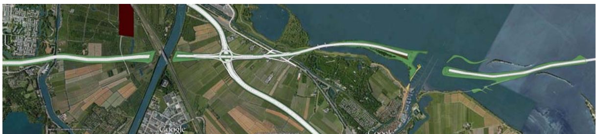
aansluiting Gaasperdammerweg | aquaduct AR-kanaal | knooppunt Diemen | knooppunt Muiden | aquaduct Muiden | IJmeerbrug
